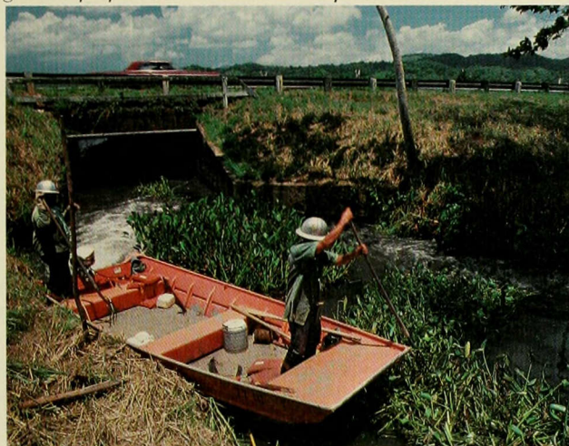
Impulsados por la corriente adicional que crea el motor de fuera de borda, los jacintos acuáticos son empujados por alcantarillas que pasan por debajo de la Carretera Gaillard a un estanque para ser recogidos allí.
