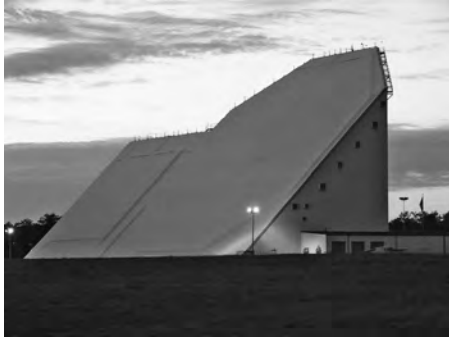
Figure 19-4. AN/FPS-85 PAR at Eglin AFB. (USAF photo)
