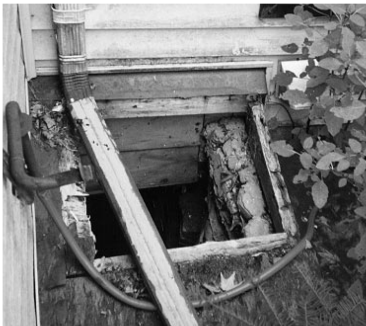
Broken cellar bulkhead door
